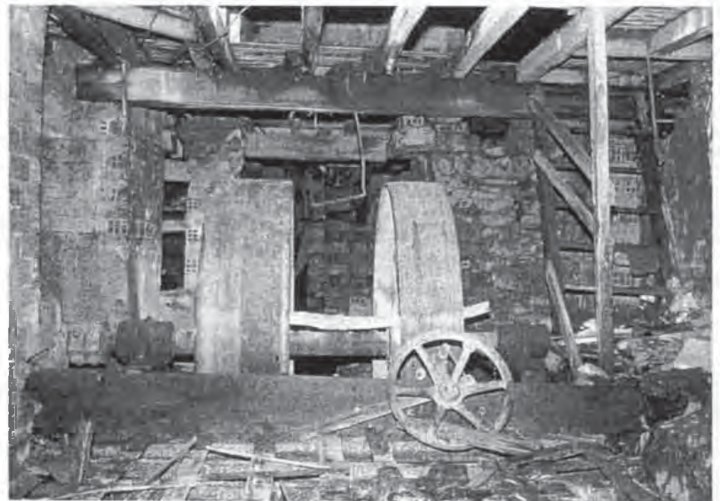
Vista de parte de la maquinaria hidráulica subterránea de la extinguida empresa Besaya S.A. (Sta. Cruz de Iguña), encargada de trasladar la fuerza del agua al movimiento de las máquinas de la serrería, etc.
